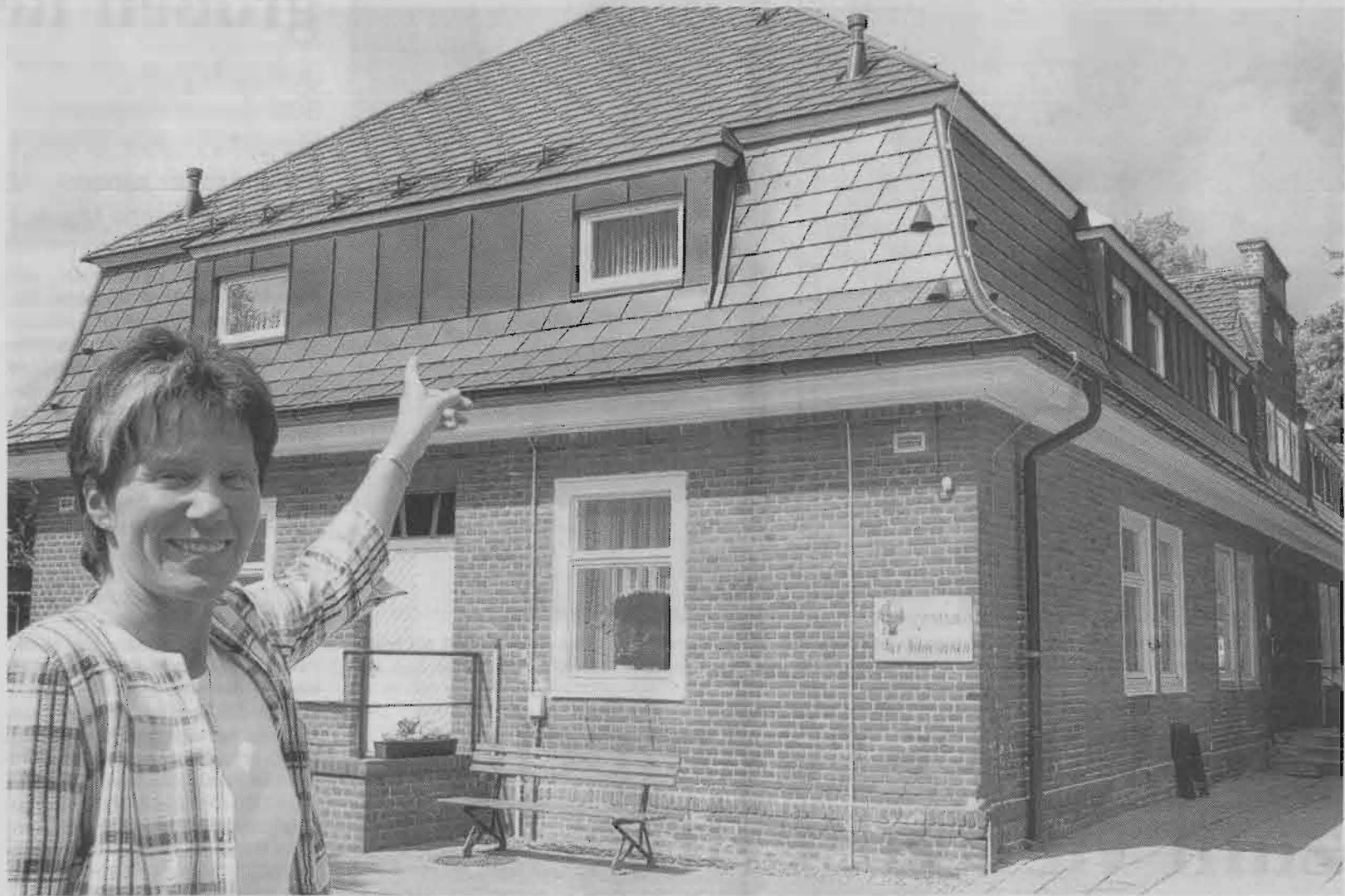
Simone Tetzlaff, Leiterin des AWO-Wohn- und Betreuungsverbundes in der Schwedter Straße, zeigt stolz auf die neu gedeckten Dächer ihrer Einrichtung. 470 000 Euro sind in diese Baumaßnahme, die von der „Aktion Mensch“ unterstützt wurde, geflossen.
